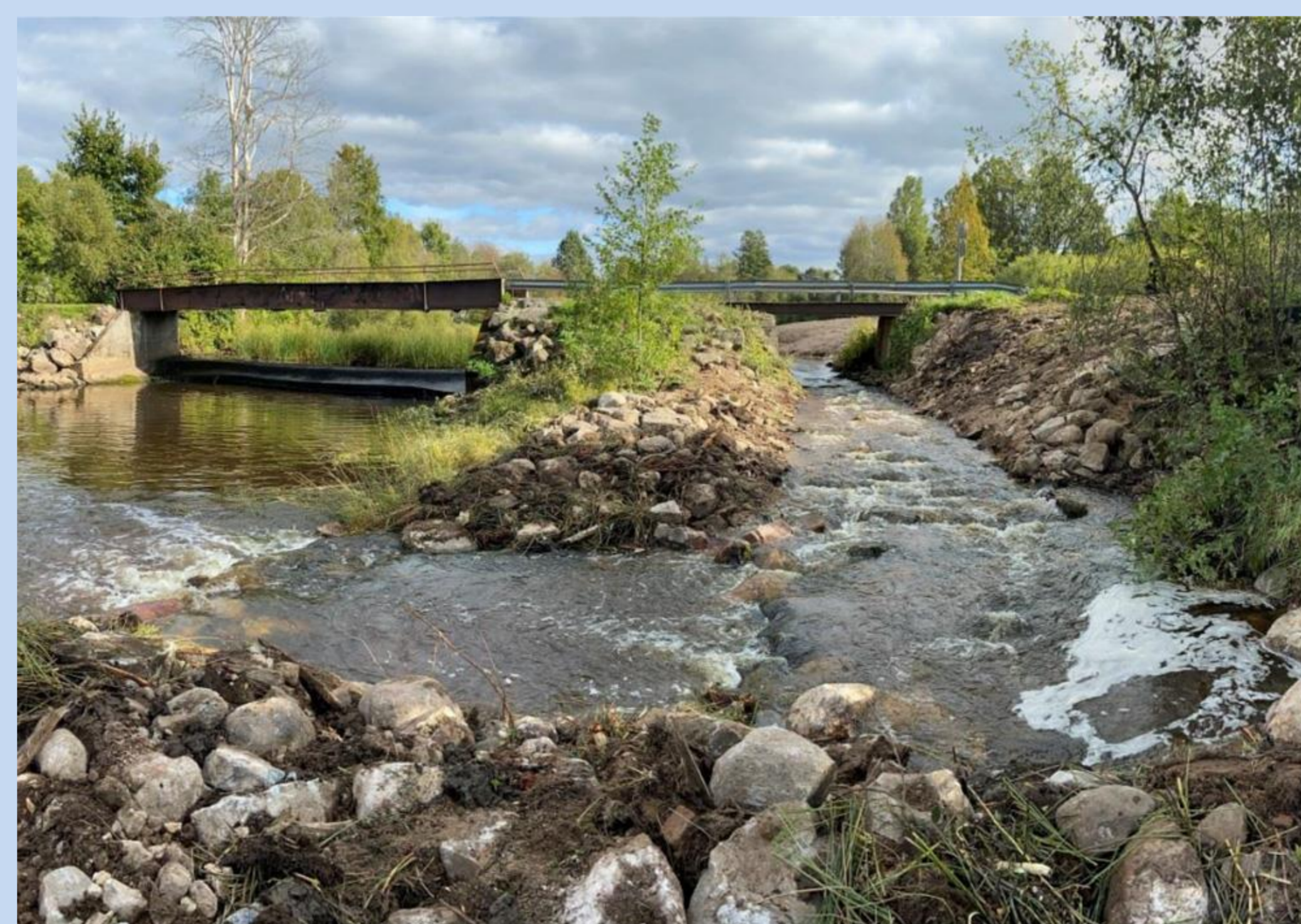
Joonis 4. Lagunenud saeveski varemed Laadiveski paisul Reiu jõel takistasid siirdekalade liikumist ülesvoolu (vasakul üleval), kalapääsuks ümberehitatud kanal (paremal) ja mõjuala kaart paisust ülesvoolu (vasakul all). Fotod ja skeem: Mark Pahk
